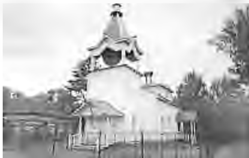
Основной вид на объект
