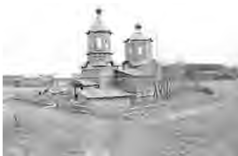
Общий вид на объект
