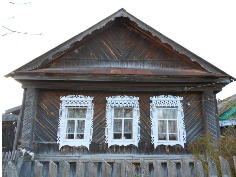
Общий вид на объект по ул. Матросова
