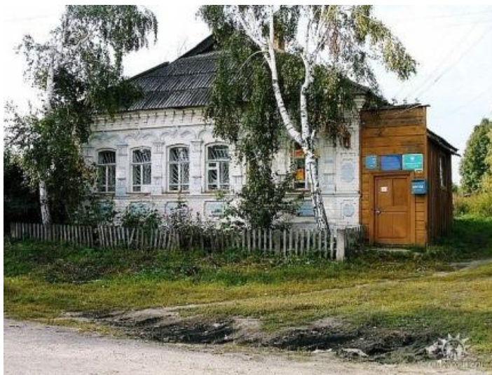
Общий вид на объект с ул. Кольцевая
